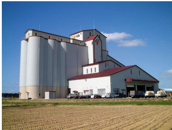
最新の設備を誇るカントリーエレベーター
