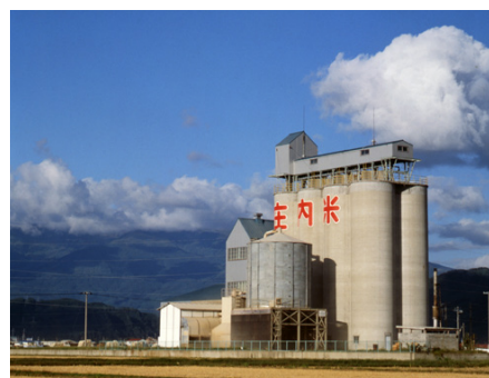
収穫した籾〔もみ〕を乾燥させる大型の乾燥施設カントリエレベータ
